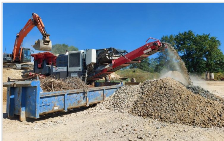
Photo 3 : concasseur et pelle à chenille, avec caisson mobile.
